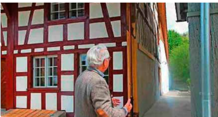
Ein Gang zwischen Jahrhunderte alten Gebäuden. Links das Haus Wytttenbach mit den Gästezimmern und rechts die Wand der in einen Pferdestall umgenutzten Scheune.
